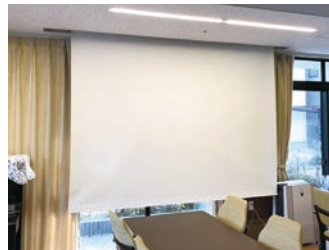
ミニシアター設備
