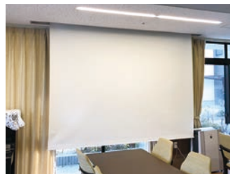
ミニシアター設備
